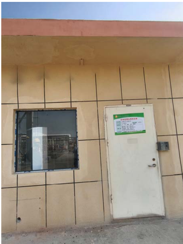
废水总排口在线监测设备房
