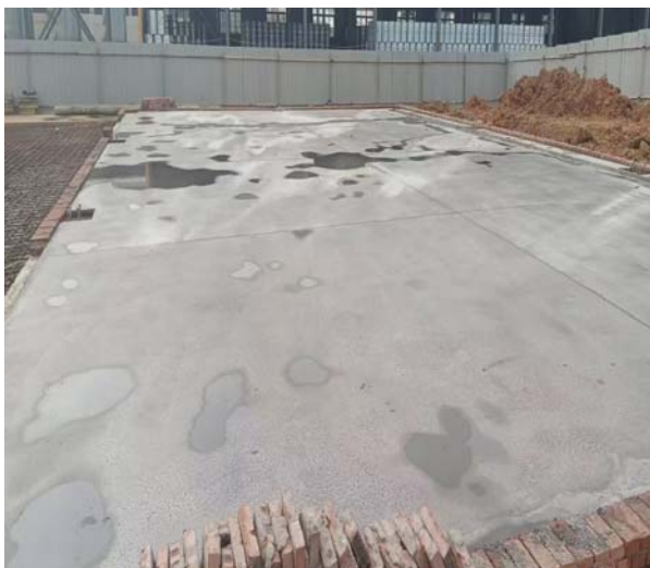
危险废物库房施工照片
