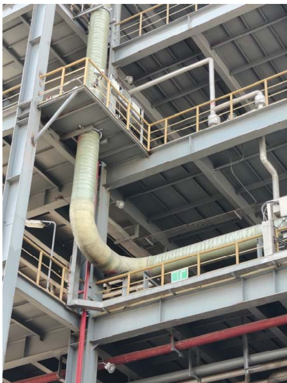
焚烧炉废气排放标识牌
