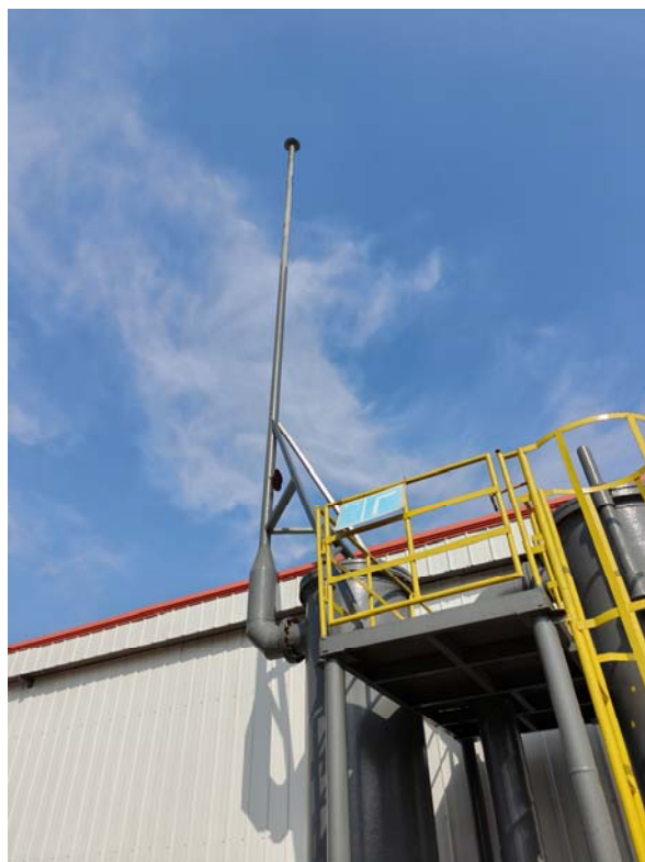
危废仓库废气排放标识牌
