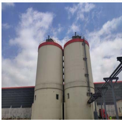
灰库布袋除尘器
