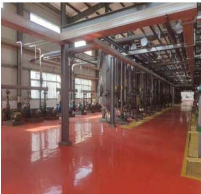
化水车间防渗防腐
