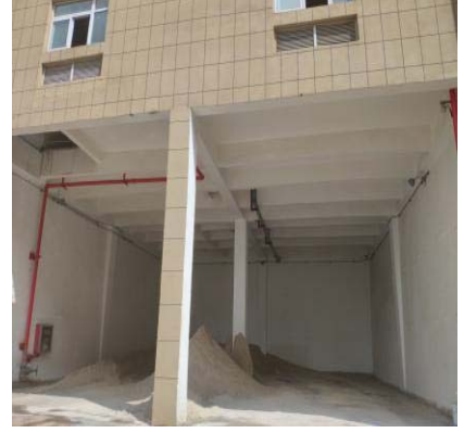
石膏库地面防渗
