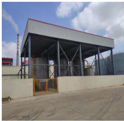
罐区地面防渗
