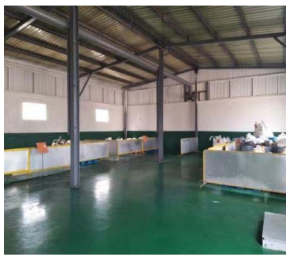
危废仓库地面防腐及围堰
