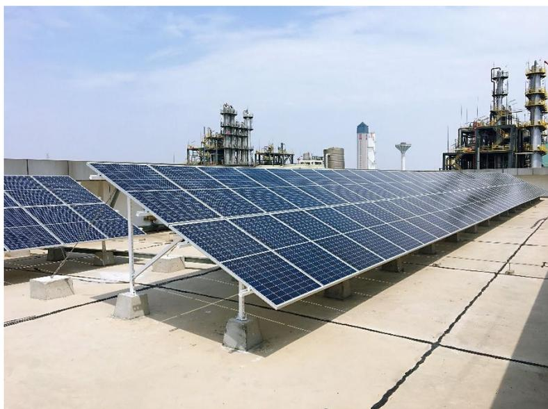
近日，我司 800 办公楼屋顶分布式光伏发电系统及双氧水氧化尾气涡轮膨胀制冷发电机组顺利并网运行发电。800 办公楼屋顶光伏发电组件由阿特斯阳光电力提供的 132 块 CSI3K-285W 多晶硅组件组成，装机容量 37.62kW，预计全年发电量约 4.5 万 kWh。双氧水
