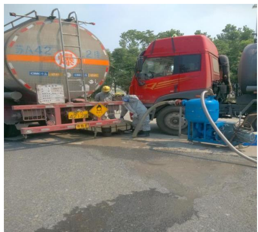
理文化工对漏点封堵
