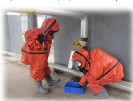
抢修人员正在抢修
