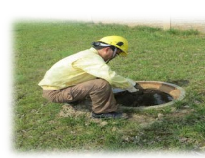
检测雨水排放口水质
