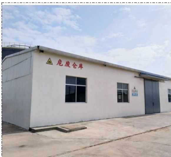
危险废物库房
