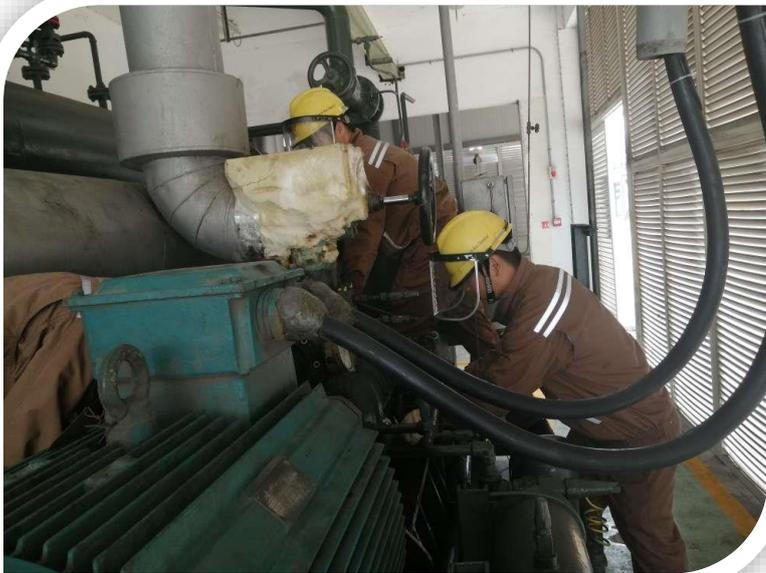
生產每日影響 40 噸折百城，為此機修全體人員連夜搶修連續奮戰 15 個小時，艱苦付出，順利完成配件安裝，經過調試，運行數據良好，震動檢測在正常範圍內，三期冷凍機經過檢修，燒鹼負荷也得到了提升。
