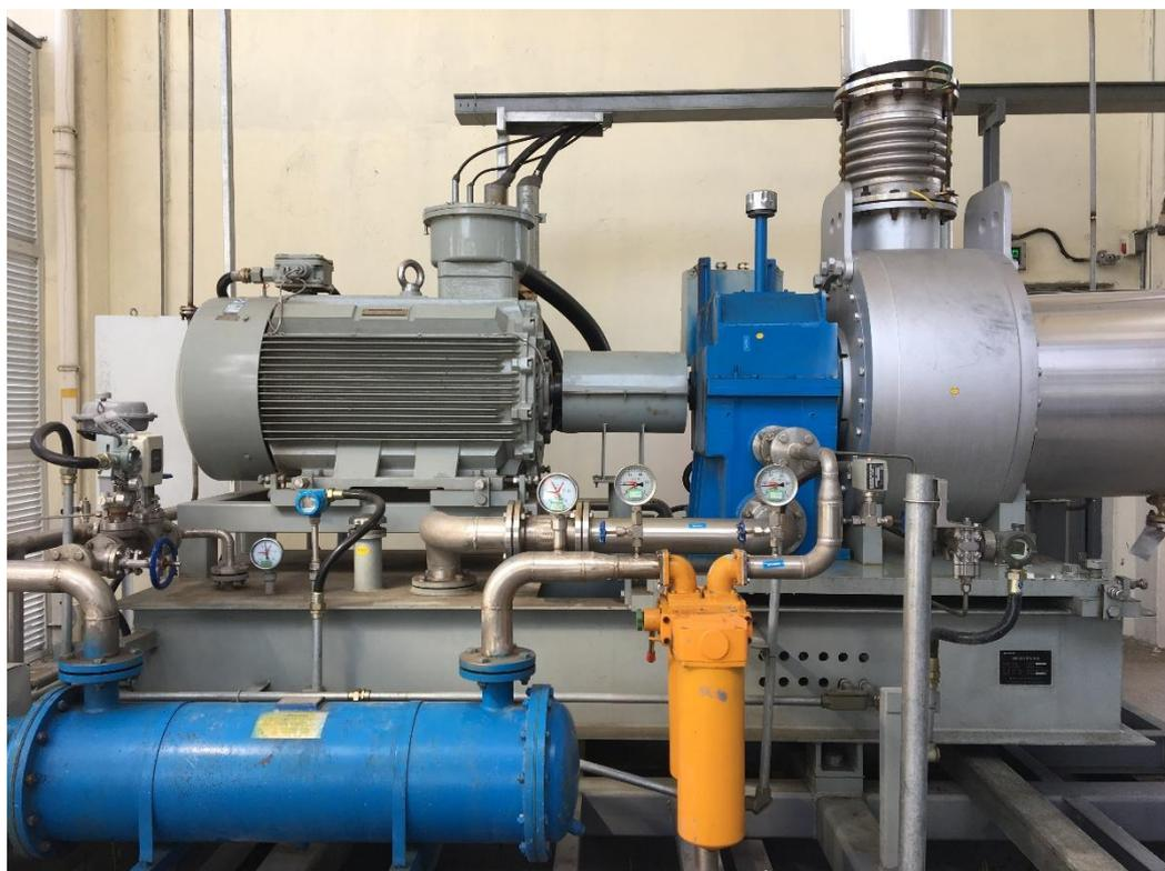
渦輪膨脹製冷發電機組是利用雙氧水氧化系統空氣反應後的餘量進行做功製冷，從而將氧化尾氣中的芳烴蒸汽冷凝液化回收利用，以減少芳烴原料的消耗和對環境的影響，膨脹做功吸熱同時可產生電能用於裝置動力電供給，降低裝置生產成本。
