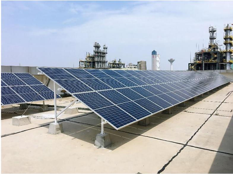
近日，我司 800 辦公樓屋頂分散式光伏發電系統及雙氧水氧化尾氣渦輪膨脹製冷發電機組順利並網運行發電。800 辦公樓屋頂光伏發電元件由阿特斯陽光電力提供的 132 塊 CSI3K-285W 多晶矽元件組成，裝機容量 37.62kW，預計全年發電量約 4.5 萬 kWh。雙氧水
