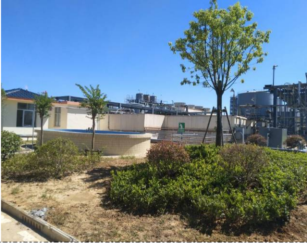
理文化工污水处理站
