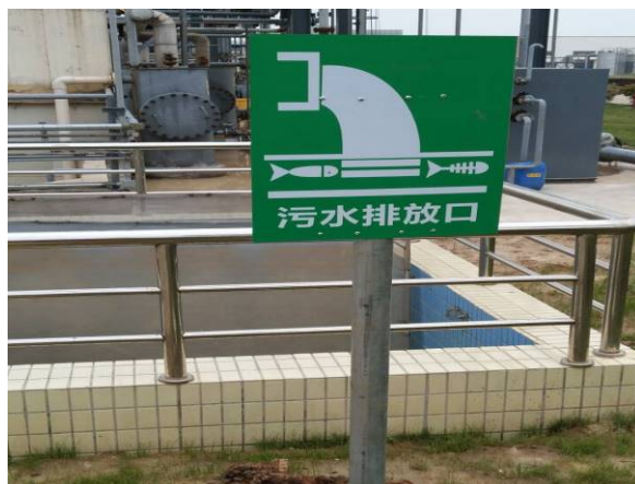
废水排放口标识牌
