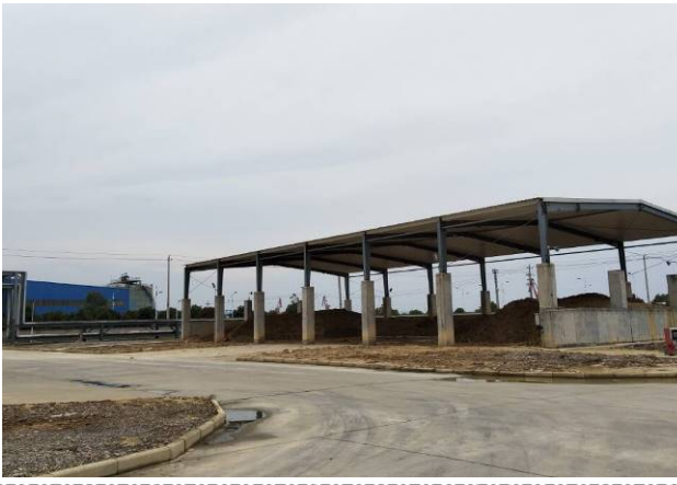
一般工业固废暂存库
