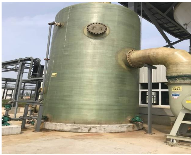
喷雾干燥工序水洗塔
