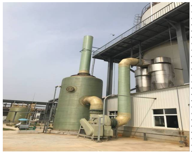
喷雾干燥工序排气筒
