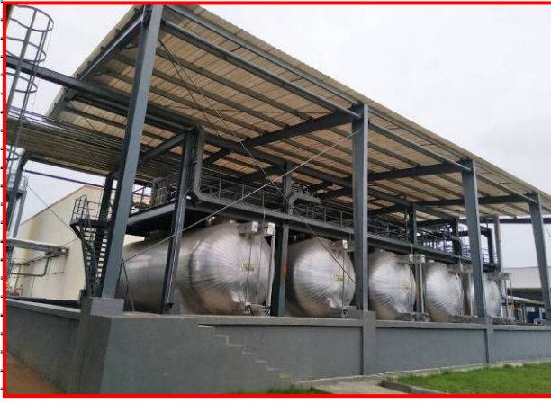
二氧化硫罐区围堰
