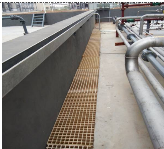
储罐区围堰及排水沟
