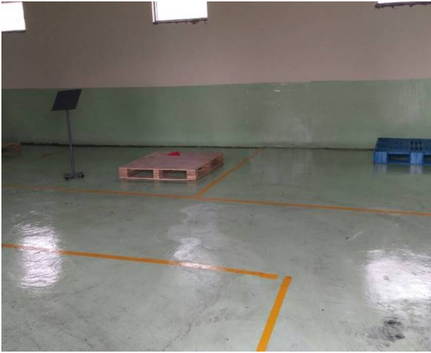
危废密闭、分区暂存措施
