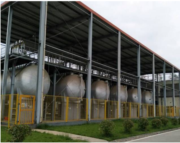
液氯罐区围堰
