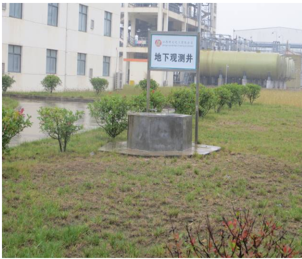
厂区地下观测井
