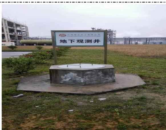
地下观测井标识牌
