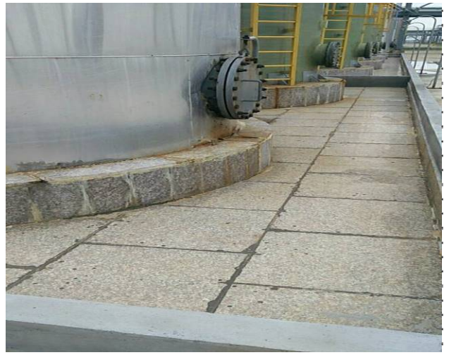
装置罐区地面防腐
