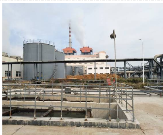
脱硫废水收集池
