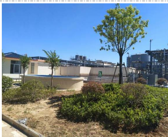
厂区污水处理站
