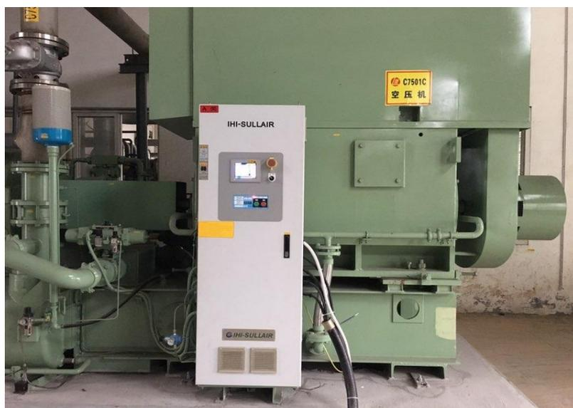
生產部多次討論、實際調研，制定出了改造方案，利用離心空壓機替代螺桿機運行，滿足實際生產需求，達到高產氣量，低消耗的目的。經初步核算,本次改造每年經濟效益增加約為 116 萬元，節約標煤 310tce ；
