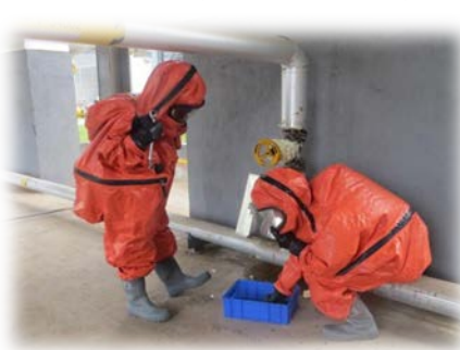
搶修人員正在搶修
