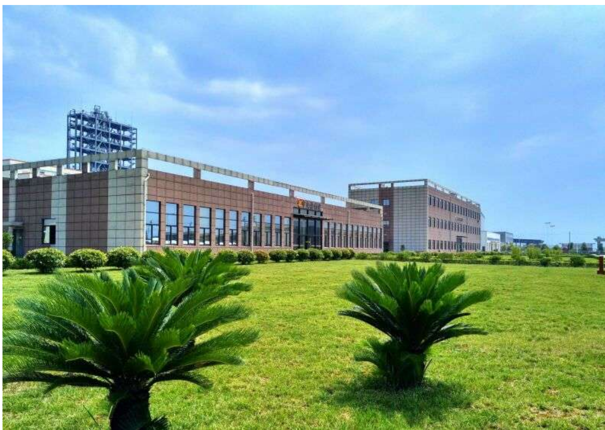
氟化厂中央控制室
